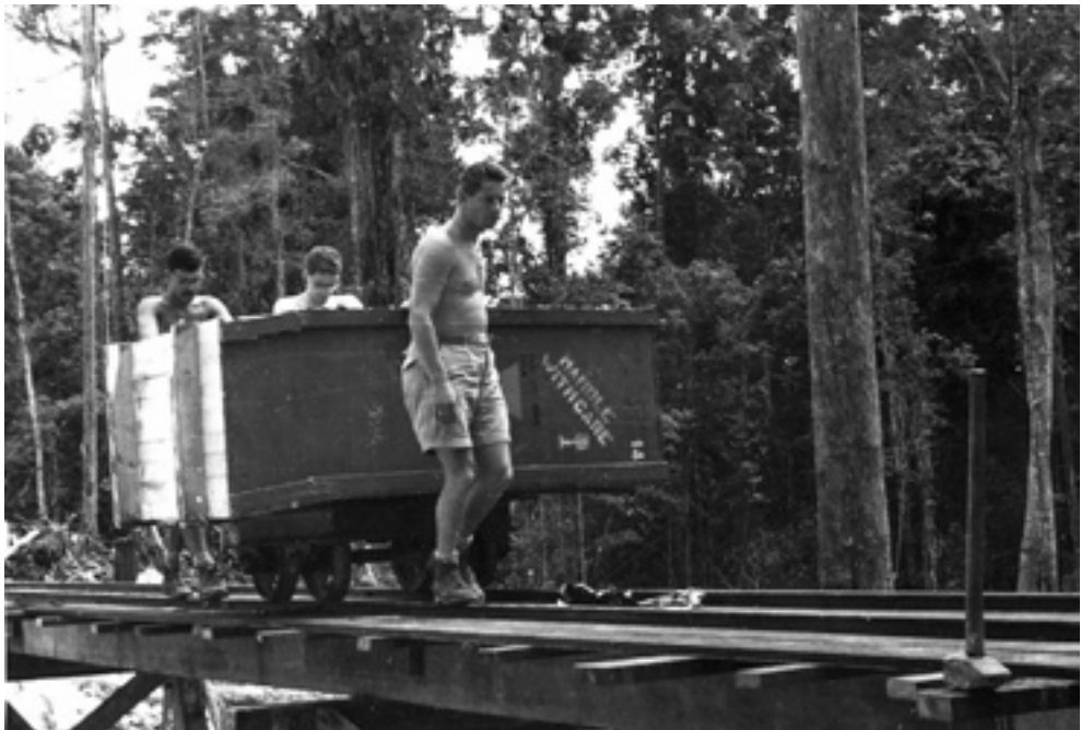
De enige spoorbaan in Nieuw-Guinea: een stukje smalspoor van dertig meter waarover de radarapparatuur met mankracht naar de torens en het gebouw werden geduwd.
