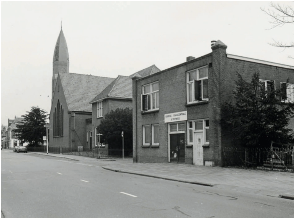
De Opstandingskerk met het kaaspakhuis op de hoek van de Wilhelminaweg en de Julianastraat. Achter de kerkzaal zijn de hoekige vergaderzalen en kosterwoning te zien. Sinds de jaren zestig woont er achter de kerk geen koster meer. (Foto RHC Rijnstreek en Lopikerwaard, X2410)
