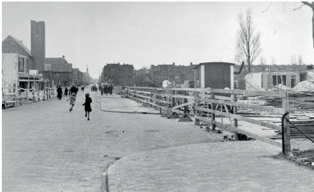
In Den Haag verdwenen hele straten voor de bouw van de Atlantikwall in 1943, zoals een deel van Westduin. Gevolg: een stroom geëvacueerden. (Nationaal Archief Den Haag, Fotocollectie Anefo)
