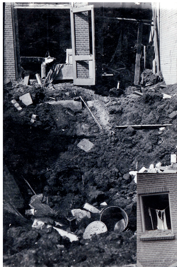
◀ Rechts ervan het eveneens fors beschadigde pand Stationsweg 9 van het waterleidingbedrijf De Elf Gemeenten. Daarboven, op nr. 9 - 1 woonde het gezin van M.W. Weerman, directeur van het waterleidingbedrijf.
